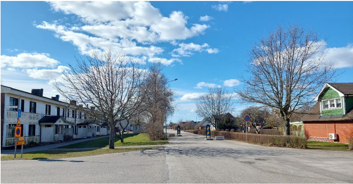
Bild 13. Ingemarsvägens befintliga utformning.
