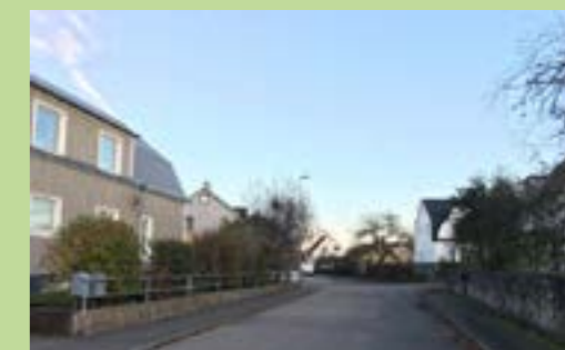
Tranebergsvägens krökning gör att husen hamnar i fonden och området upplevs som flera sekvenser istället för en enda. Vägen har ett tydligt gaturum med trottoar, förgårdsmark och byggnad.
