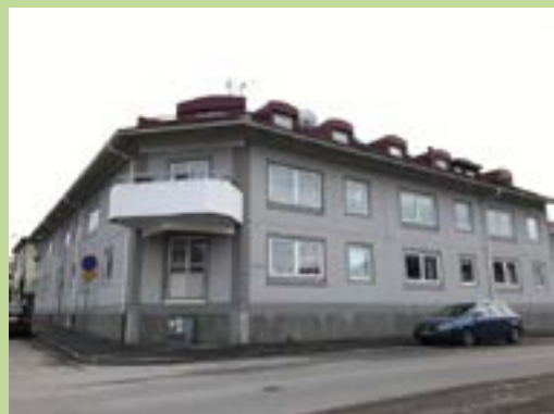
Öppen kvartersstad. Byggnader av olika bredd och höjd bildar tillsammans tydliga kvarter
