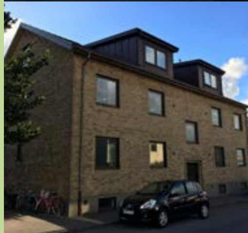
Små äldre flerbostadshus. Friliggande, i allmänhet placerade mot gata centrerat på tomten
