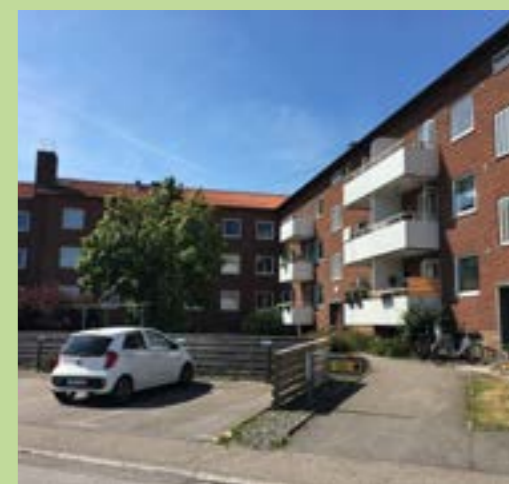
Äldre lamellhus på Egnahemsgatan. Entréer sker från den gemensamma gården där också lekplatser och viss parkering finns. Andra sidan möter gatan med en liten förgårdsmark
