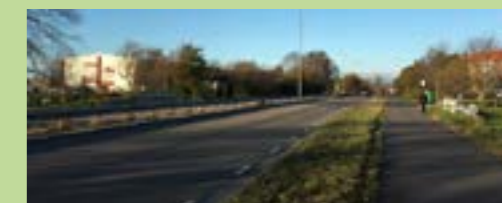
Väst kustvägen med Brunnsberg till höger. Bred bilväg med separat g/c-bana. Vägrummet flyter ut i gräsytor och annan växtlighet.
