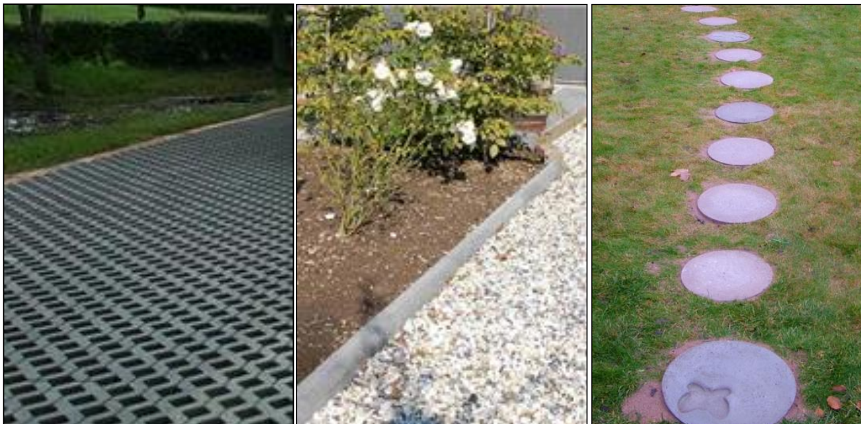
Figur 21. Yta med hålsten av betong, makadambelagd gång, samt gångstig med gräs och några gångplattor i betong (Foto: Norconsult)
