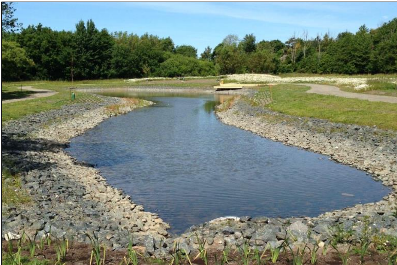
Figur 24. Exempel på dagvattendamm norr om Pilgatan i Varberg. (Foto: Norconsult)
