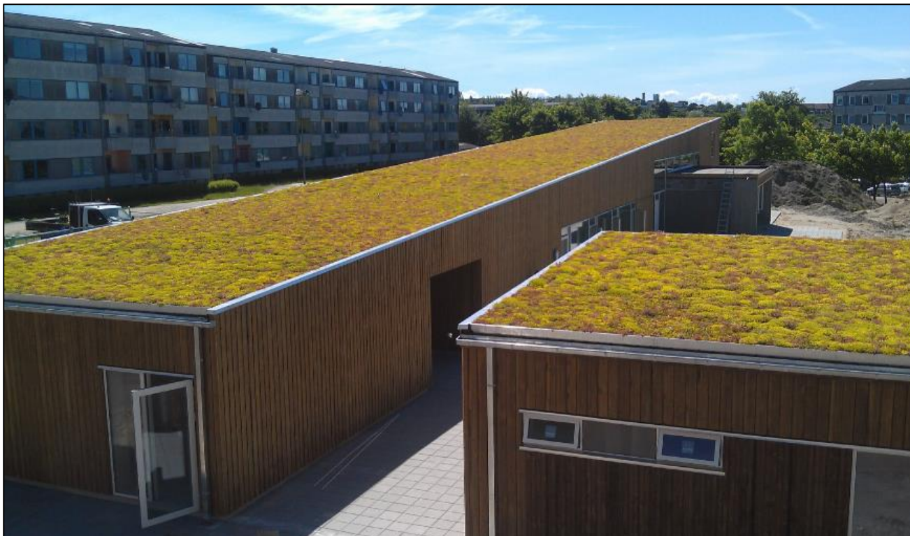
Figur 15. Exempel på sedumtak (Källa: Engman Tak AB)
