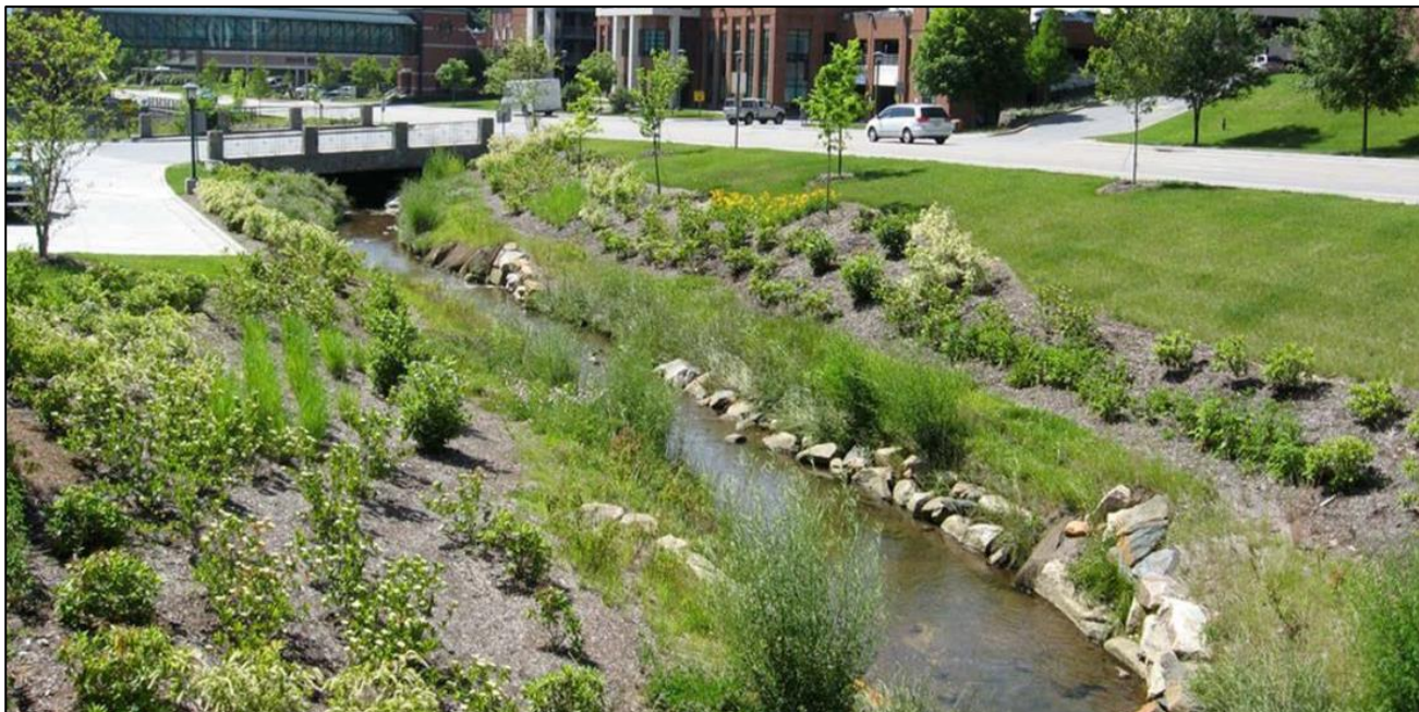
Figur 23. Exempel på ett vattenförande svackdike (Boone creek) men vegetation i slänterna (Foto: Appalachian State University).
