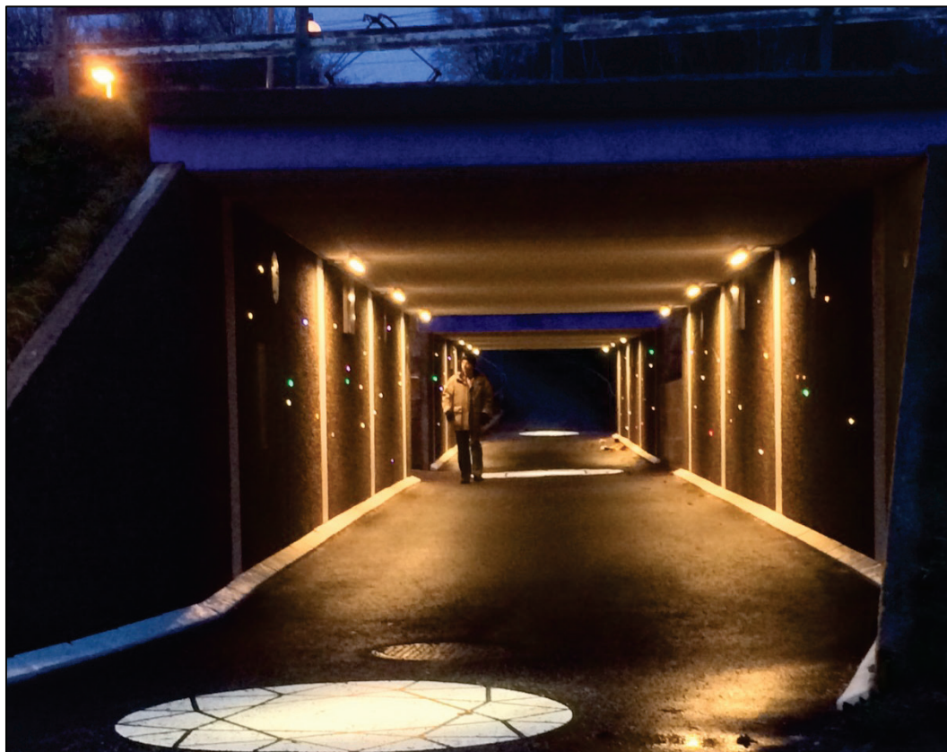
Figur 20 Exempel på belysning i gångtunnel, Tynnered, Göteborg.
