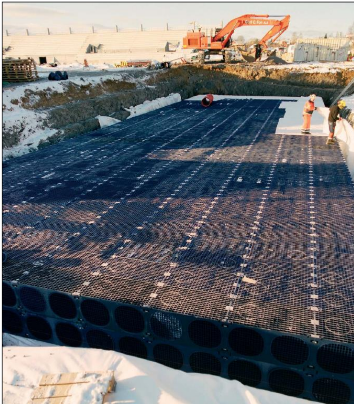
Figur 13: Exempel på utjämningsmagasin i form av dagvattenkassetter (Foto: Wavin)
