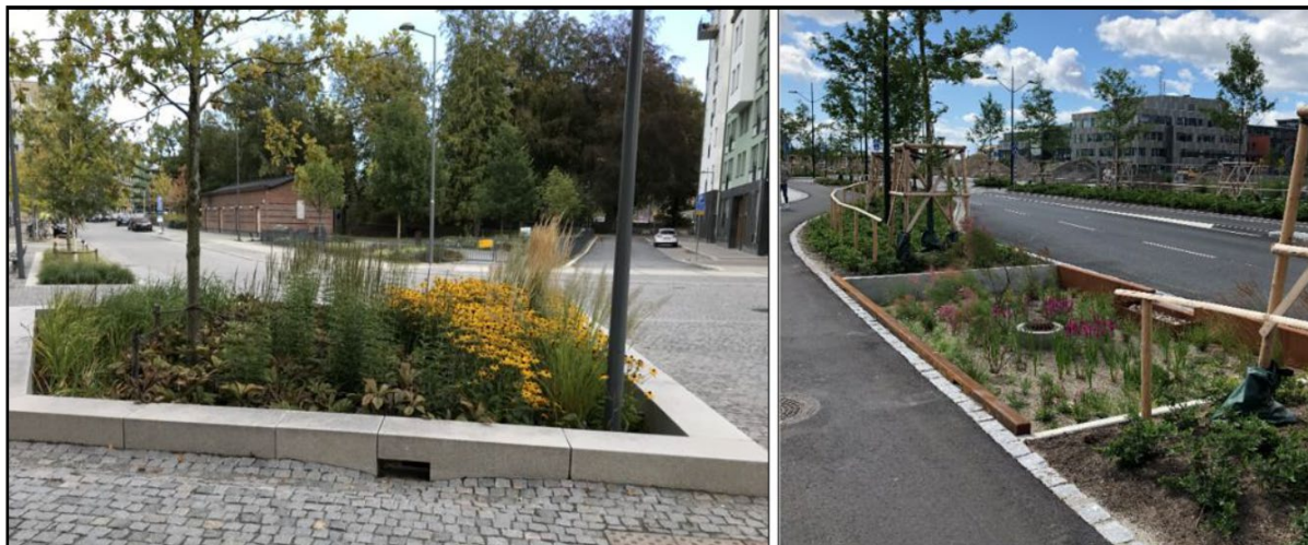
Bild 8 och 9. Exempel på växtbäddar med dagvattenhantering.
