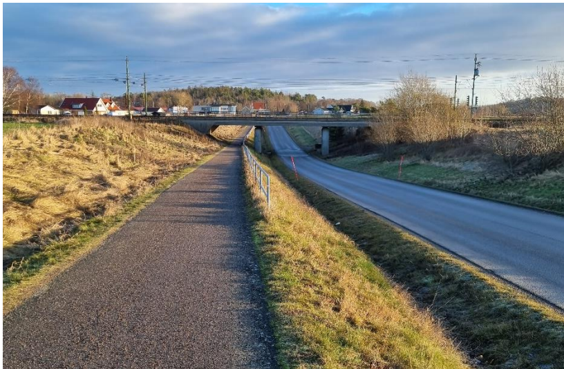
Figur 8 Järnvägsviadukt med pumpanordning. Dräneringar anlagda vid viaduktens sidor.
