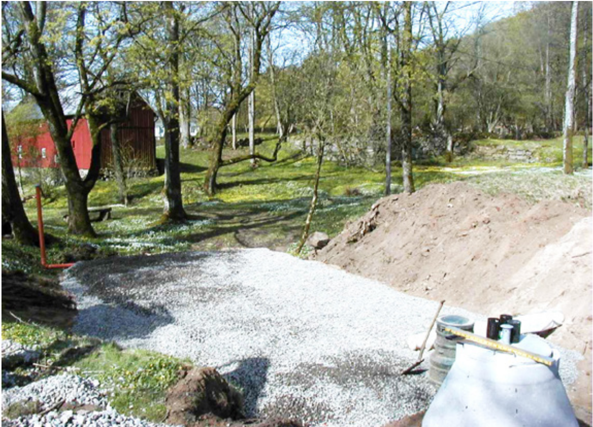
Anläggande av enskilt avlopp.
