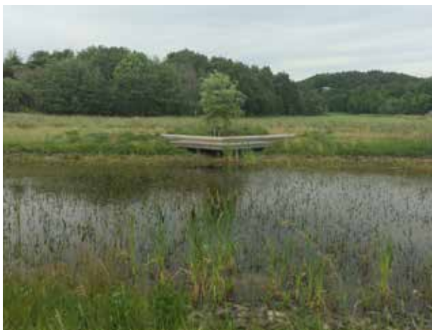
7:1 Dagvattendammar ska utformas med flacka slänter.
