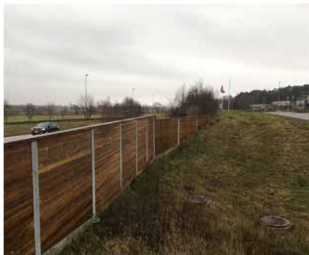
6:23 Exempel på bullerplank och bullervall.
