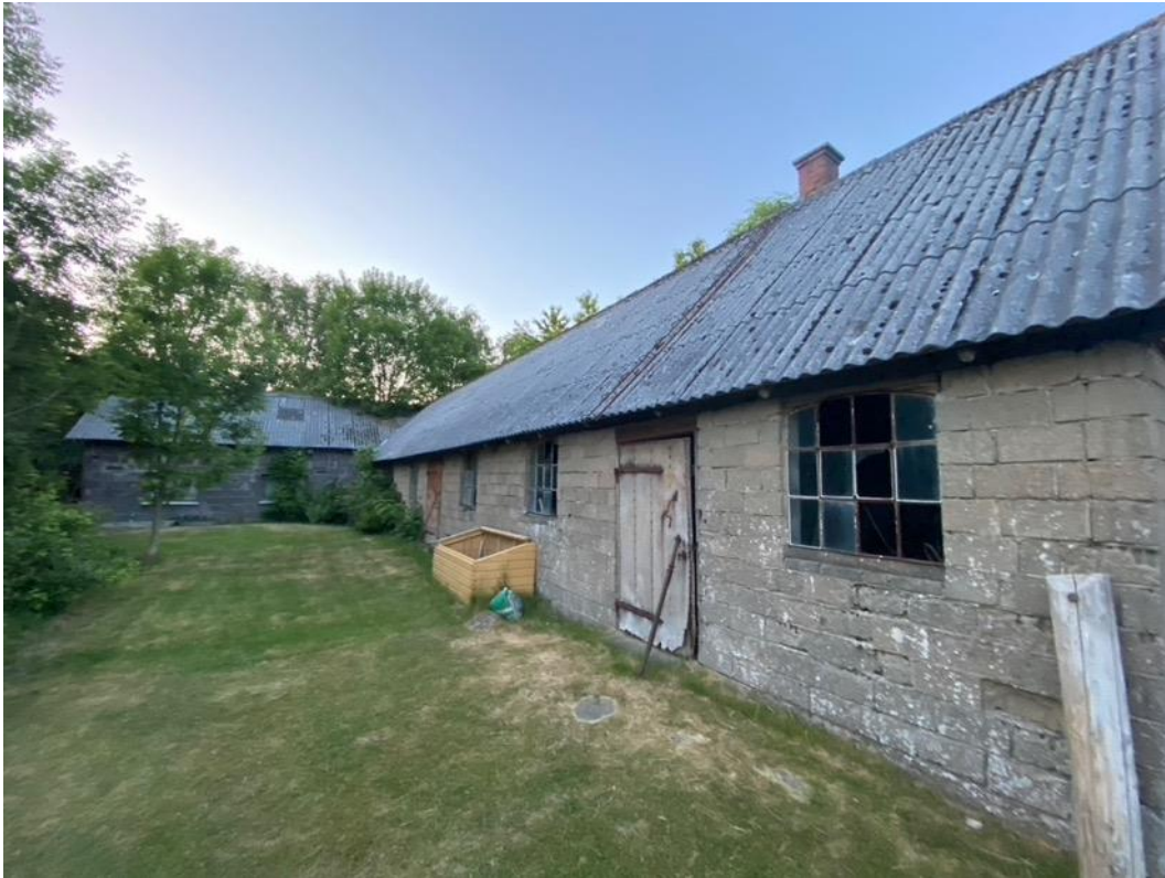
Figur 3. Hönshusets västra sida.
