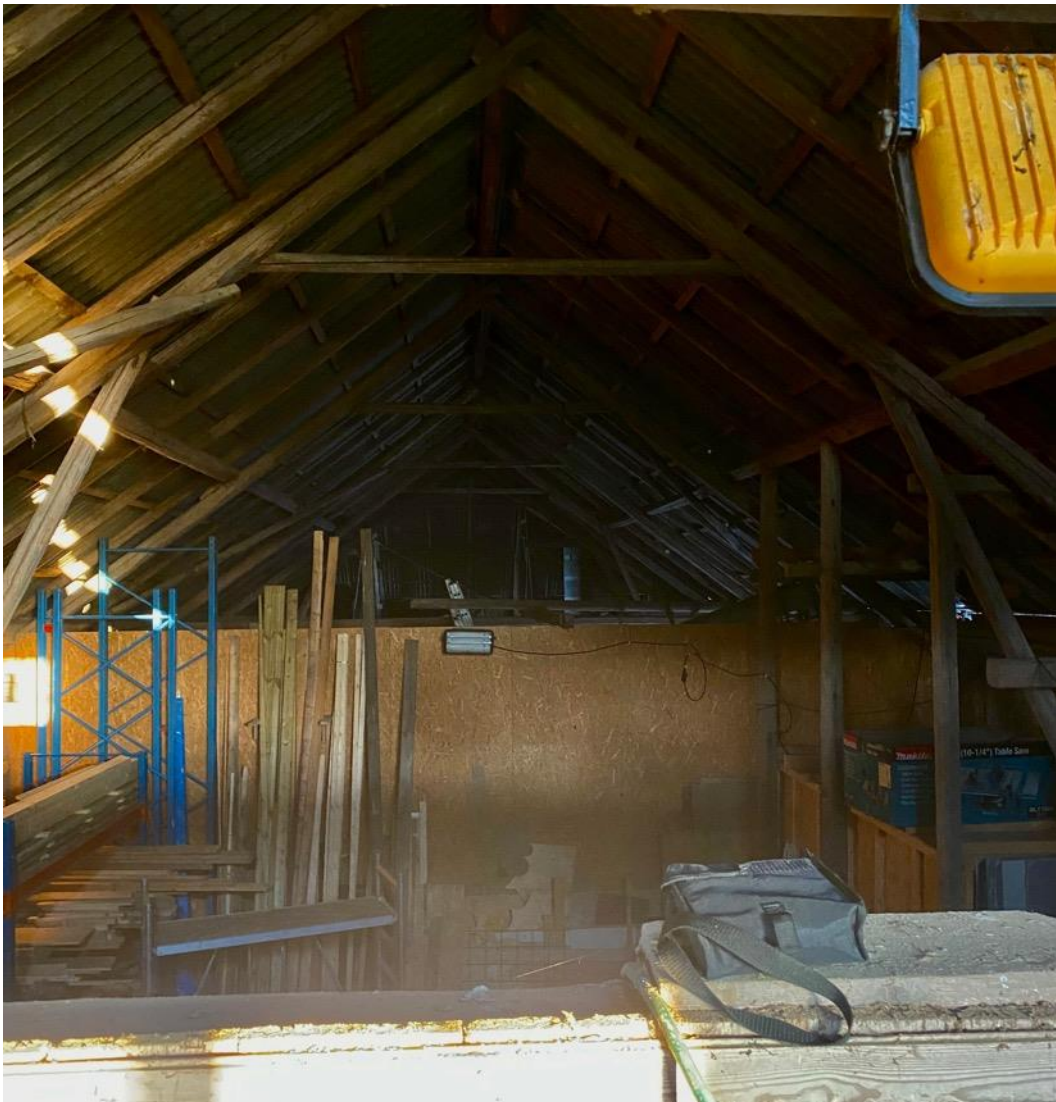
Figur 4. Fotot visar autobox 3 (den svarta lådan i förgrunden) placerad på en hanbjälke inne i stora ladugården. Vinden är öppen i hela byggnadens längd vilket gör att boxen lätt kan fånga upp läten från flygande fladdermöss i hela utrymmet.
