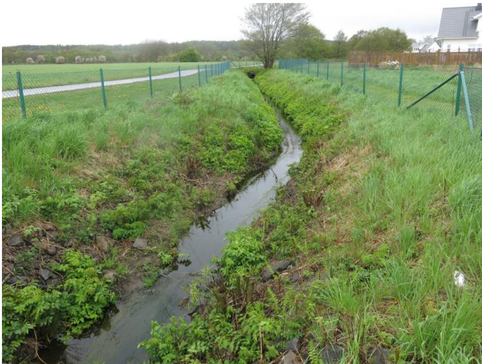
Objekt 1. Öppet dike i objektets södra del.
