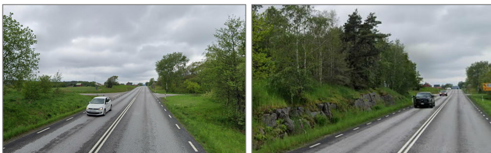
Figur 12. T.v. Korsningen väg 845 och Ulvaberget med dålig sikt vid krön. T.h. bergskärning på västra sidan av väg 845, i höjd med korsning Ulvaberget. Bildkälla: Google Maps.
