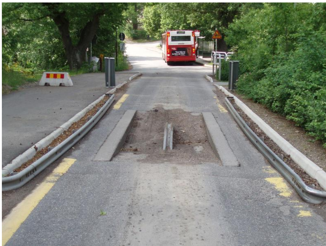
Figur 12. Spårviddshinder. Källa: Exempelbanken.se
