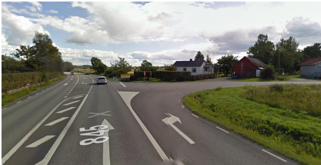
Figur 14. Korsningen mellan väg 845 och Trönningenäsvägen. Bild tagen norrifrån på väg 845. Källa: Google maps
