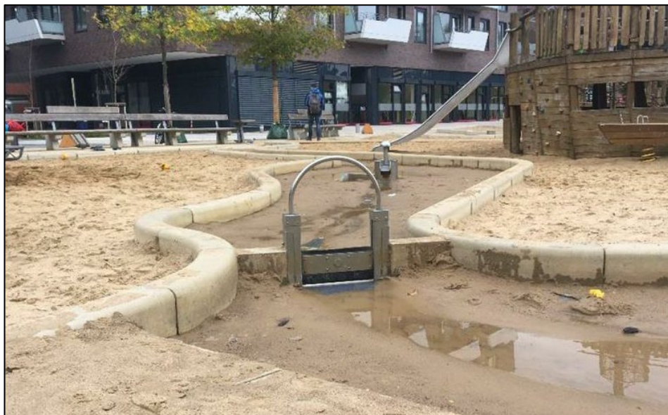
Figur 19. En säker kanal med dagvatten som kan användas pedagogiskt under regnfall.
