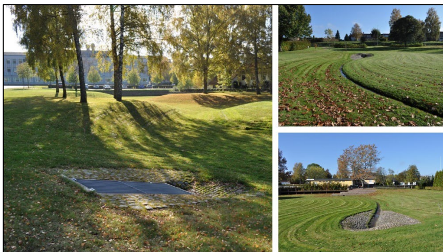
Figur 18. Exempelutformning för torrdamm.
